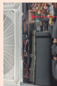
Wärmetauscher Economizer
