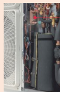
Wärmetauscher Economizer
